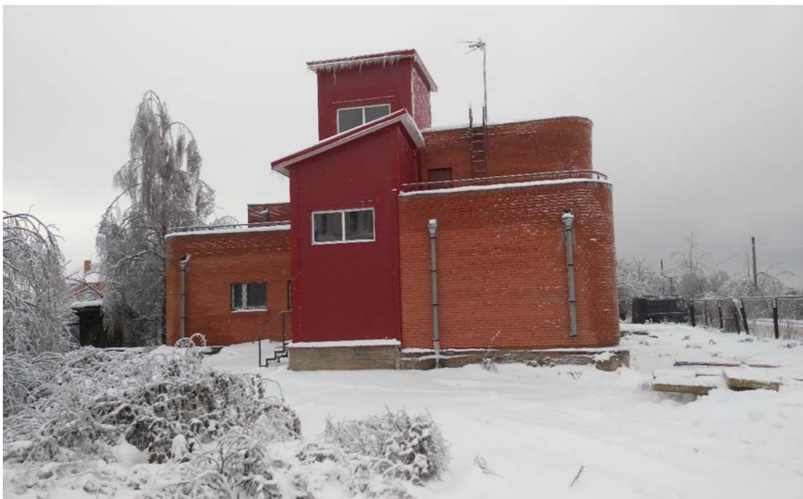
Рис. 2 Здание геодезической поверочной лаборатории геодезического полигона ФГБУ «Центр геодезии, картографии и ИПД» в с. Троице-Сельцо Мытищинского района Московской области где установлен компаратор
