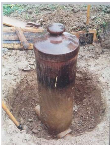
Фото 2. Центр геодезического пункта Кабози перед заливкой бетонным «колпаком». (2005г.)
